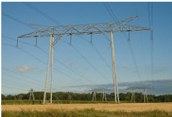
Photo d'un pylône électrique Trianon.
