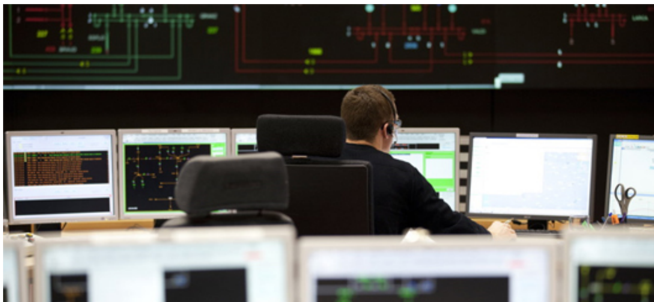
Dispatcheur surveillant l'équilibre des flux électriques sur le réseau de transport
